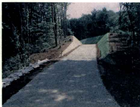
(処分場建設工事用道路)
