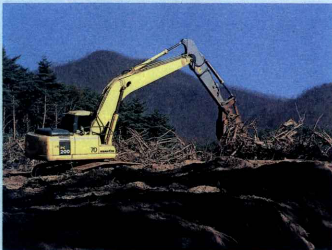
(埋立地造成工事状況)
