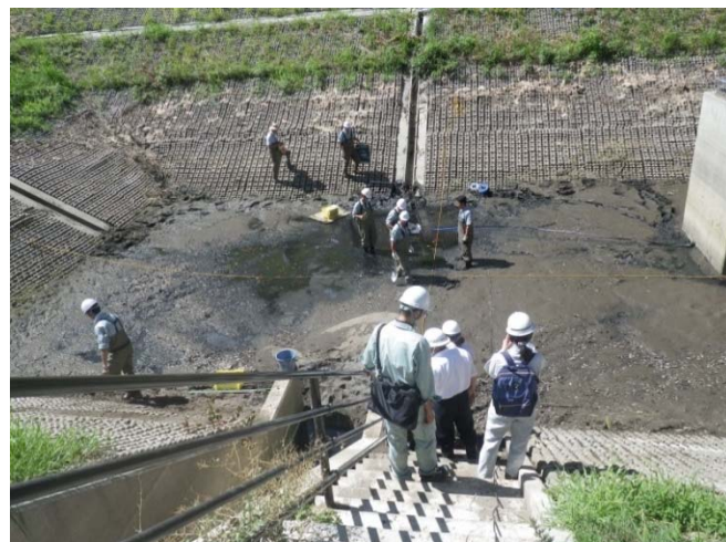
水を抜いた防災調整池の全景
