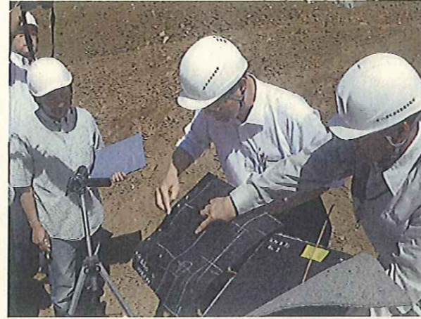
異常検知した現物遮水シートと荷重実験の比較
