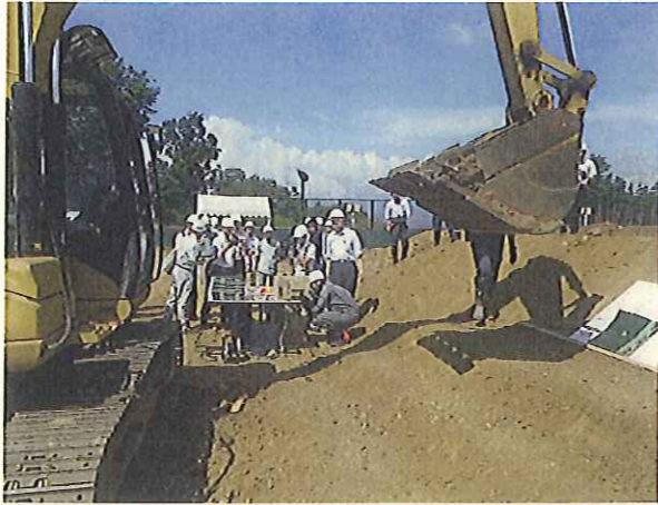
現場における荷重実験
