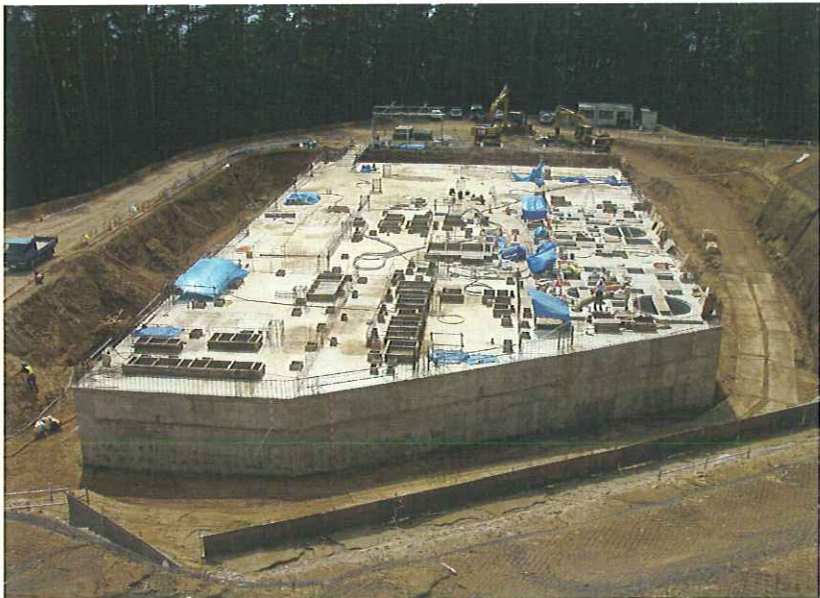
③ 浸出水処理施設敷地(調整槽)
