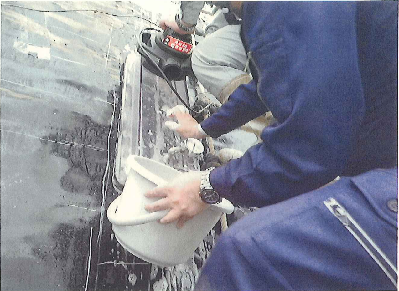
8m×8m範囲（法面部、底面部）負圧試験完了
