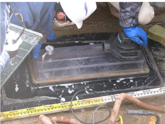
《損傷下層遮水シート負圧試験状況②》
