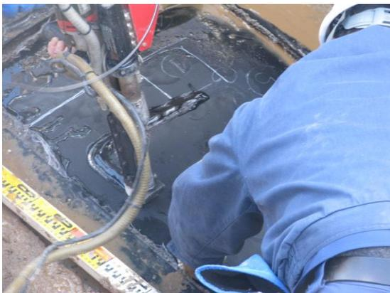
《溶着箇所の押し出し補強状況②》
