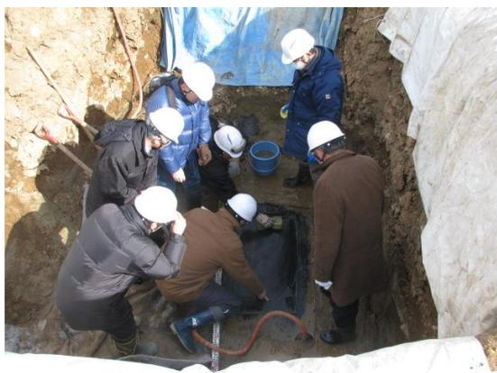
《損傷下層遮水シート負圧試験状況①》
