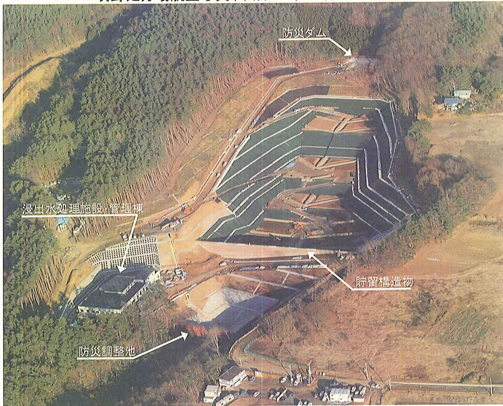
明野処分場航空写真(平成20年12月16日撮影)
