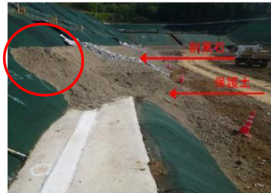
保護土及び集排水管周り割栗施工状況（右岸側法面）
