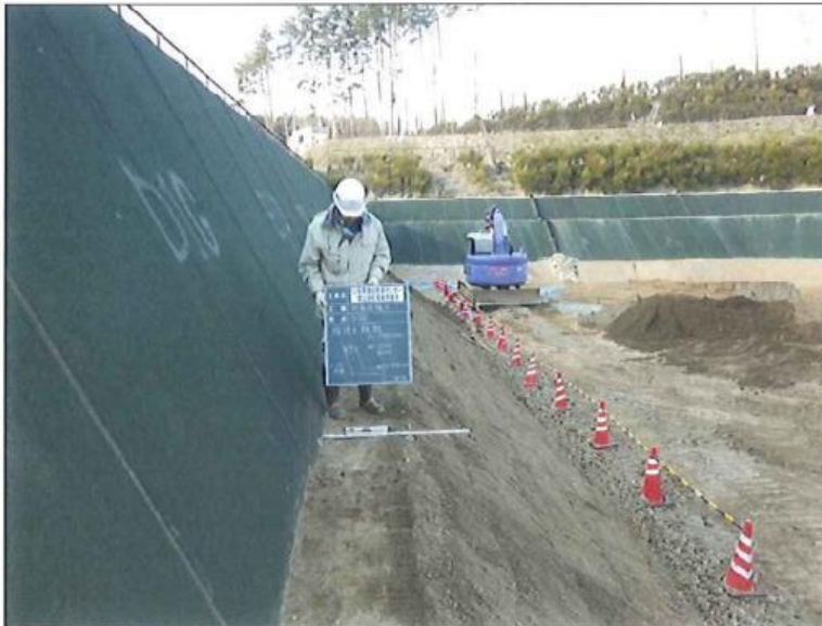
写真17 保護土厚さ検測状況 (平成24年4月9日)
