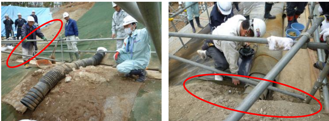
写真20 予想破損箇所遮水シート確認立会時に確認した保護土の状況 （平成25年4月30日）
