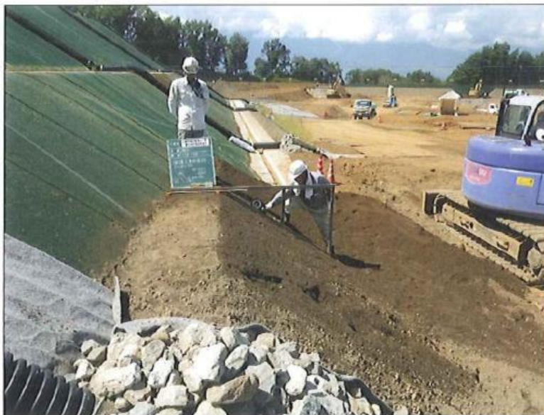
写真18 保護土厚さ検測状況 (平成24年9月12日)
