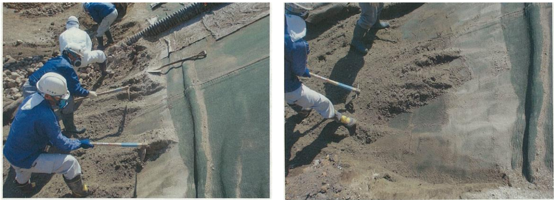
写真19 調査範囲保護土掘削状況（平成25年4月15日）
