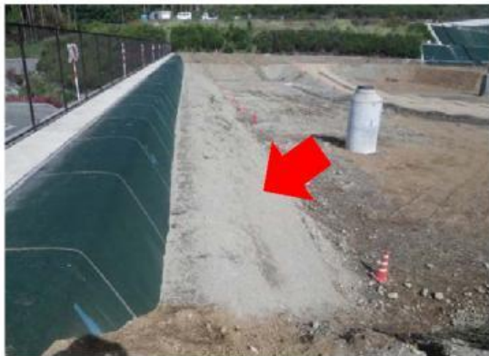
保護土施工状況（貯留構造物）
