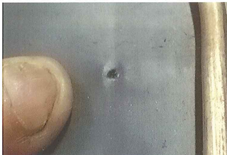
写真 16 重機による圧縮試験によって生じたくぼみ(再現性の確認)
