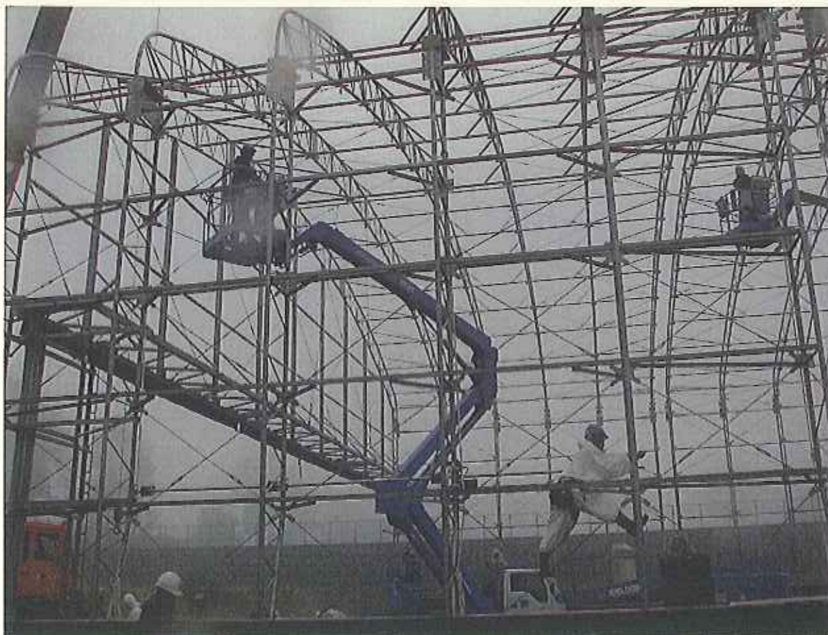
同日(11/11) 骨組み解体の状況
