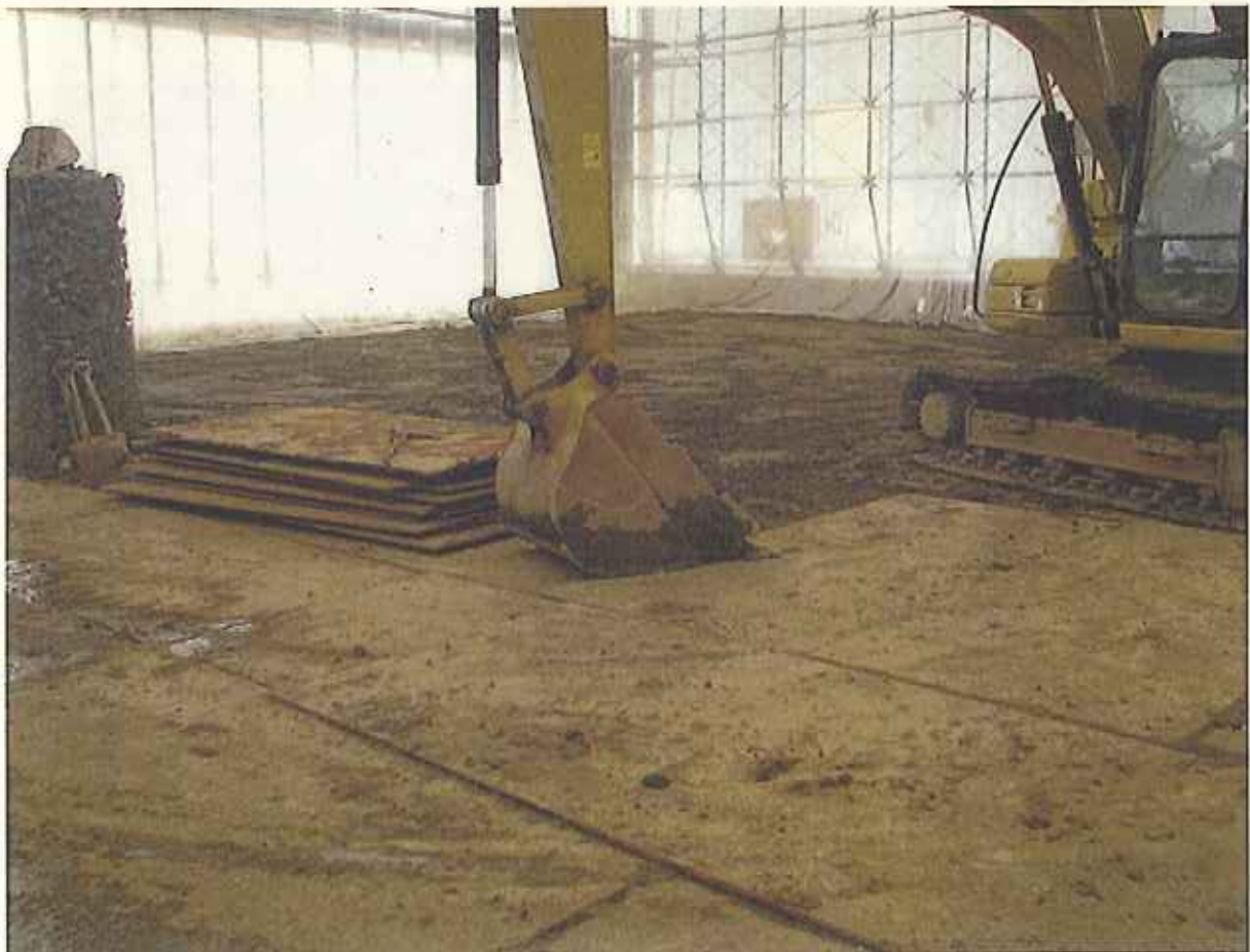
同日(11/8) 埋め戻し完了後の廃棄物仮置場所
