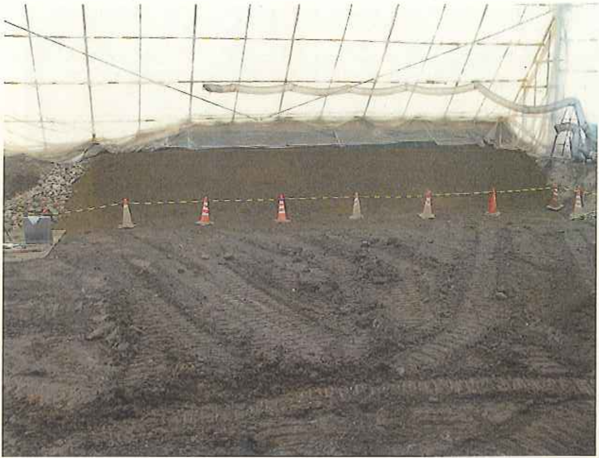
平成 23 年 11 月 8 日(火) 廃棄物の埋め戻し及び覆土完了後の掘削場所
