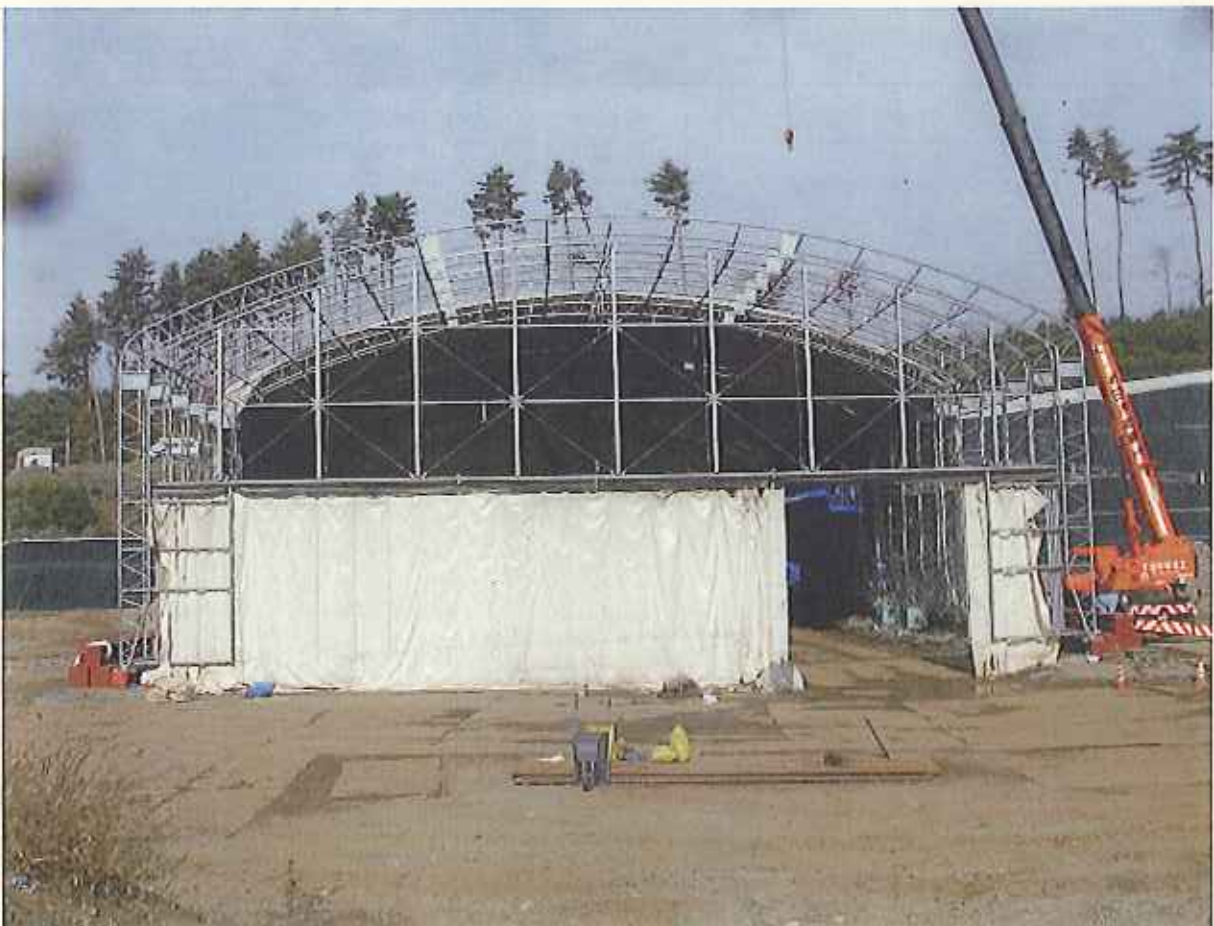
同日 (11/10) 外幕の撤去状況
