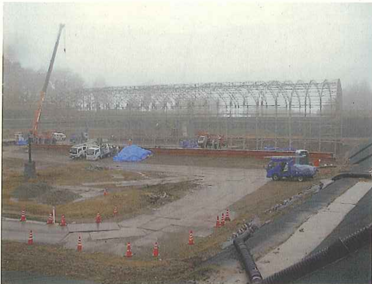
平成 23 年 11 月 11 日(金) 被覆テントの骨組み解体に着手
