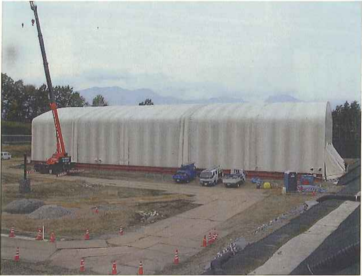
平成 23 年 11 月 10 日 (木) 被覆テント外幕の撤去に着手
