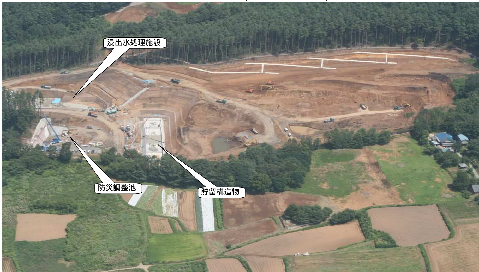
(南側より処分場全景)
