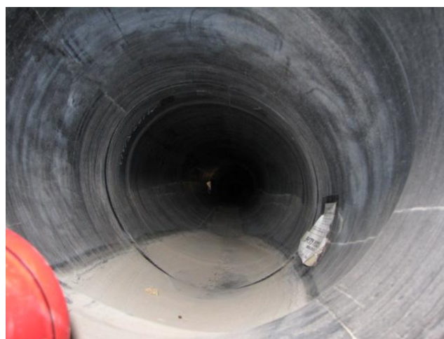
図3-2 地下水集排水管の状況(2月8日)
