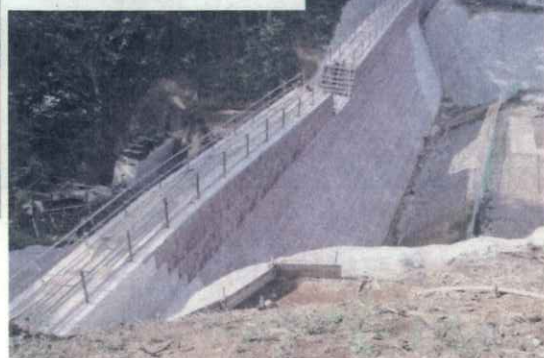
防災調整池（ダム）
