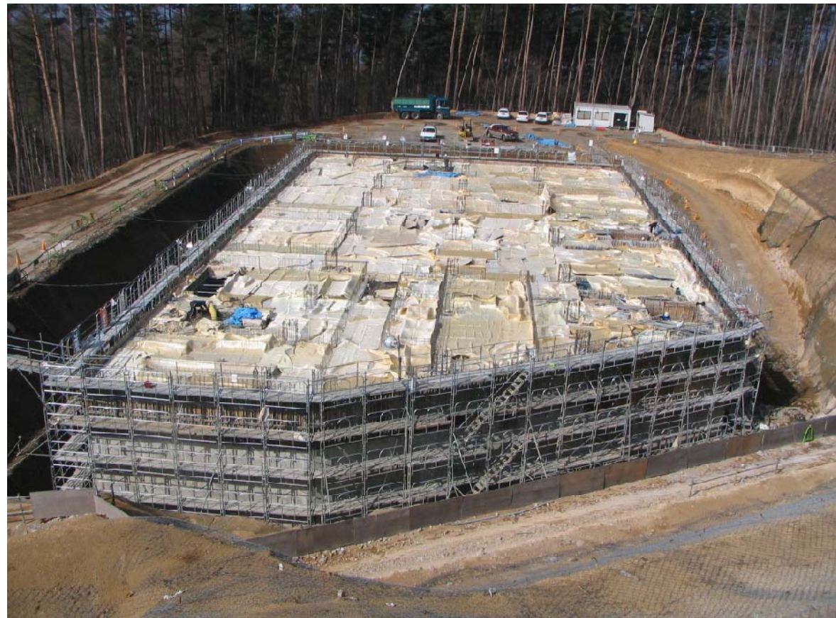
③ 浸出水処理施設敷地(調整槽)
