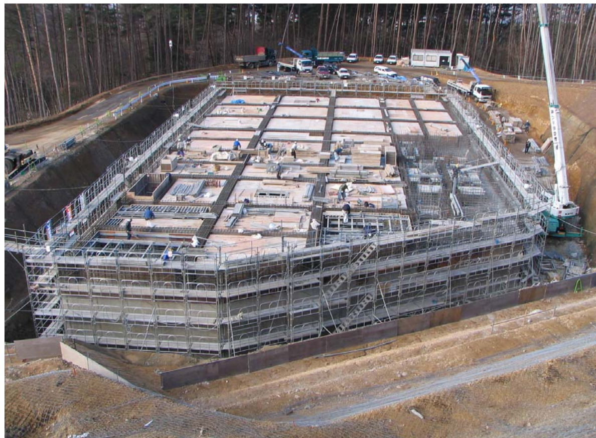
③ 浸出水処理施設敷地(調整槽)
