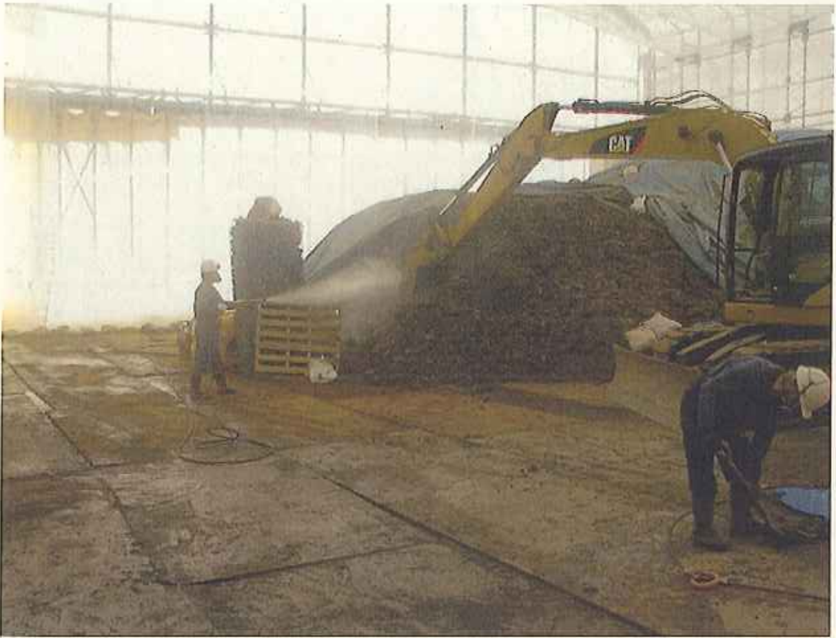
同日(10/24) 廃棄物の埋め戻し作業に着手 積み込み状況 散水し、アスベスト粉じんの飛散を防止
