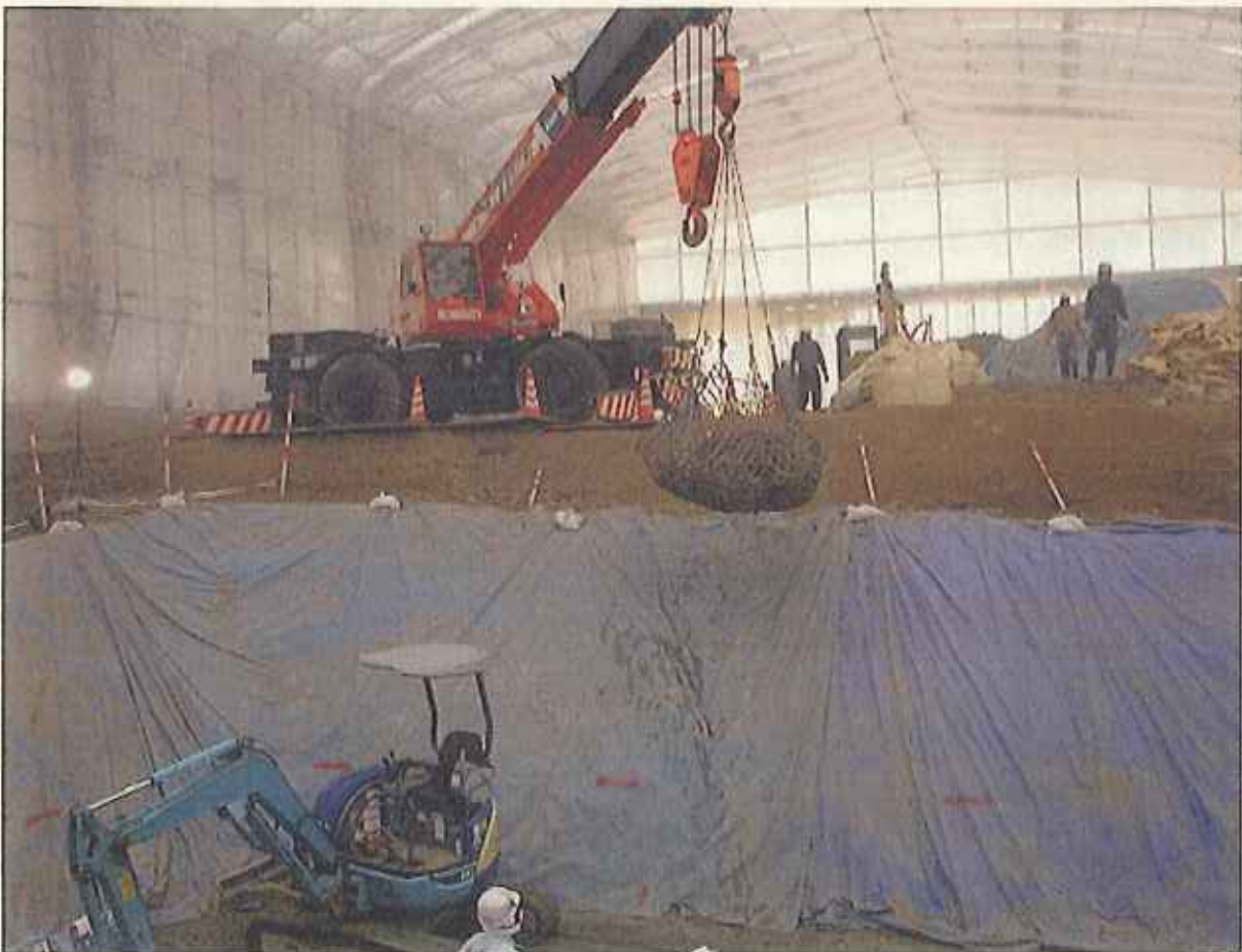
同日(10/24) 埋め戻し廃棄物をクレーンで掘削穴へ移動
