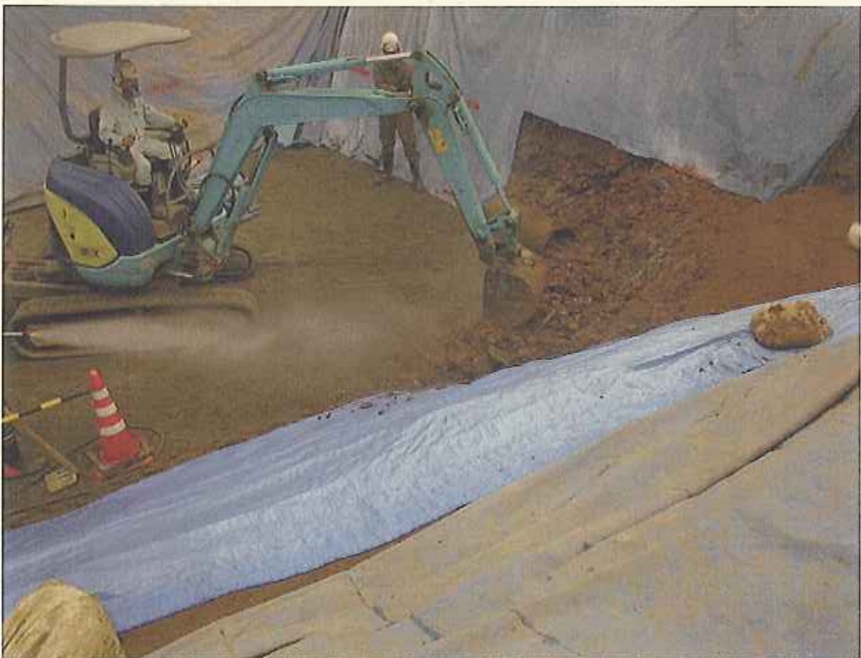
同日(10/24) 一層目の廃棄物の埋め戻し状況 この際も散水し、アスベスト粉じんの飛散を防止
