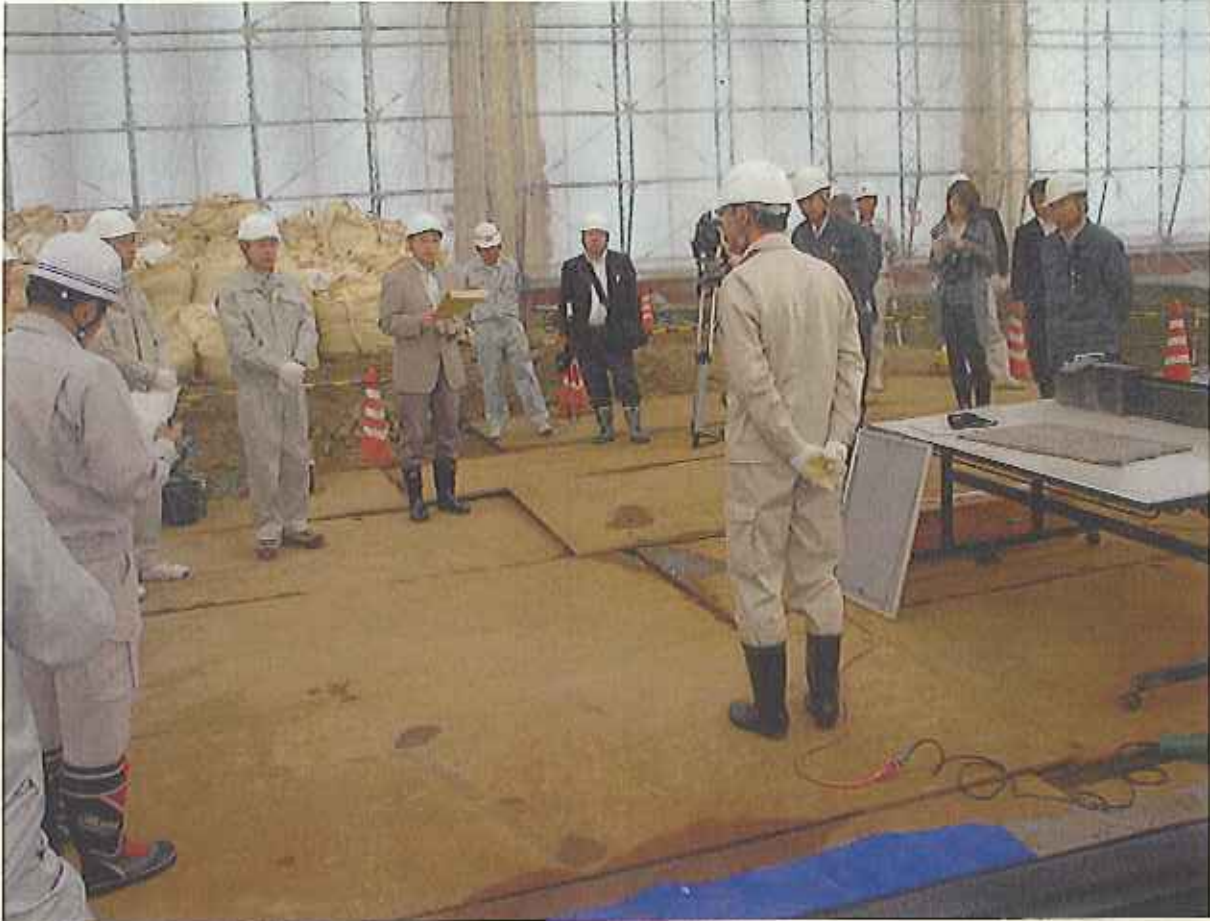
平成 23 年 10 月 19 日 (水) 埋立地被覆テント内で現地復旧作業に着手
