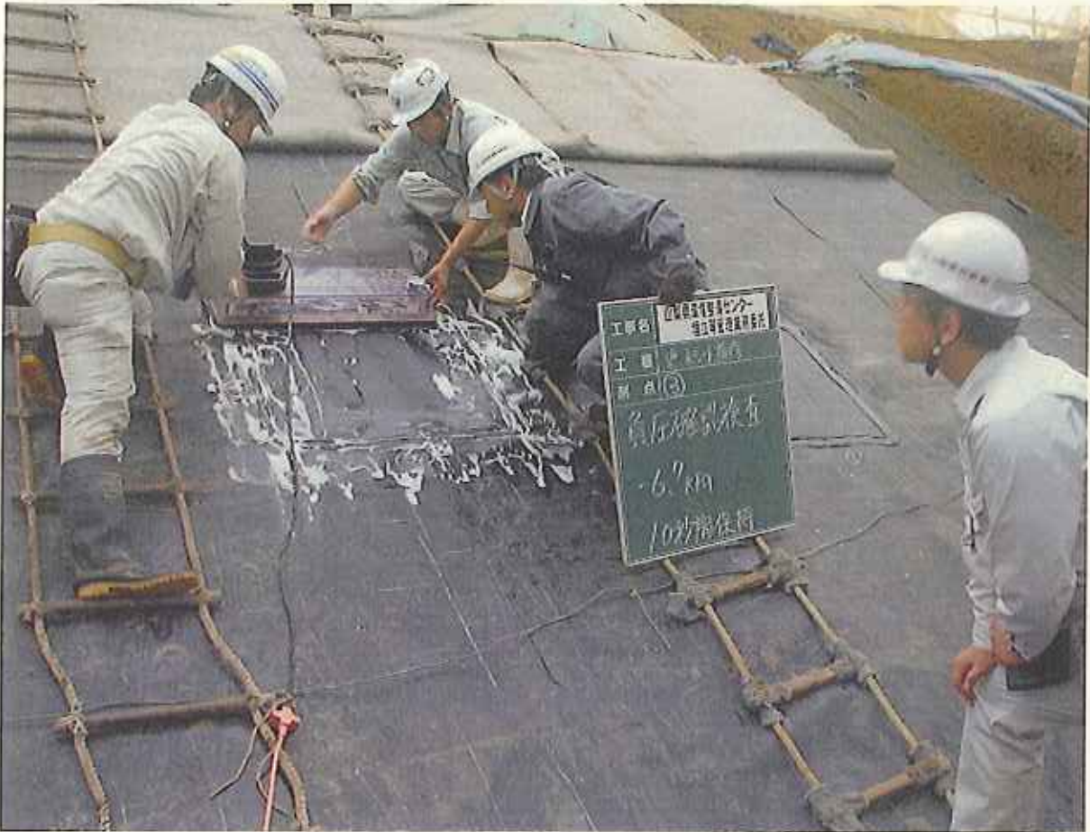
同日(10/19) 修復用遮水シートの熱溶着及び押し出し溶着後、負圧試験を実施 合格(-6.7kPa 10秒保持)
