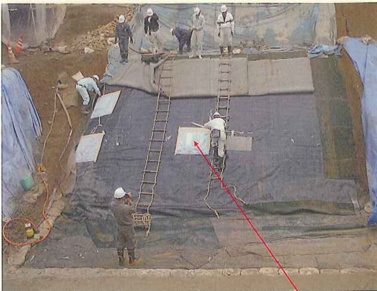
同日(10/19) 現地復旧作業前 遮水シートの修復対象部分の露出作業 原因箇所(電極交点部分)
