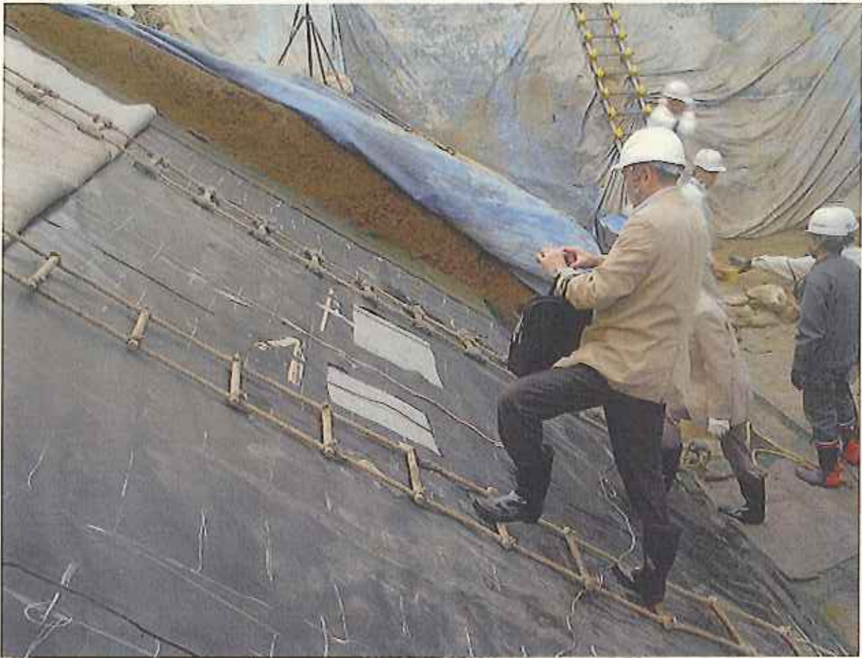
同日(10/19) 安全管理委員による前業の原因箇所(電極交点部分)の下層不織布の状況確認
