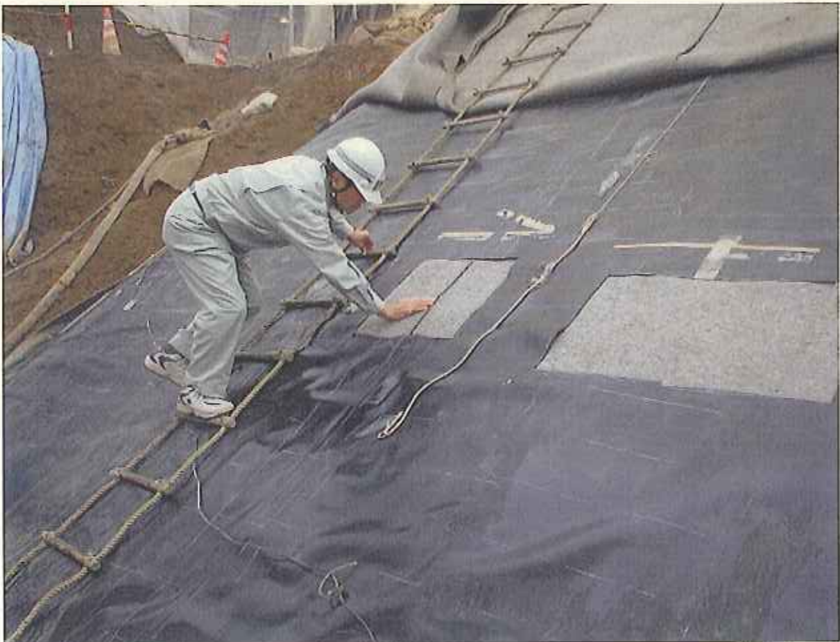
同日(10/19) 環境整備課による前葉の原因箇所(電極交点部分)の下層不織布の状況確認
